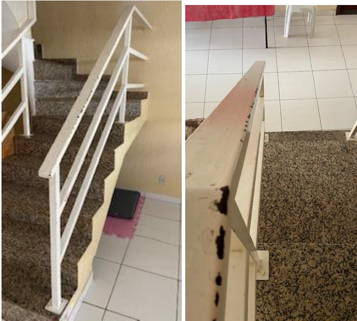
APLICAÇÃO DE PINTURA DE CORRIMÃO, TÉRREO.
